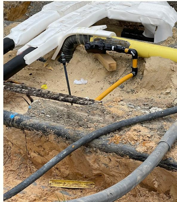
Beim Tiefbau haben wir die Leitungsumlegung für die Fernwärme abgeschlossen. Die Umlegung der bisher in der Stichstraße verlegten Medien (Gas, Strom und Telekom) ist dem Zeitplan entsprechend in vollem Gange.
